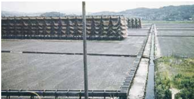
流下式塩田（白浜） 海水をポンプによって流下盤と枝条架に循環させて濃縮を行う。昭和40年代
