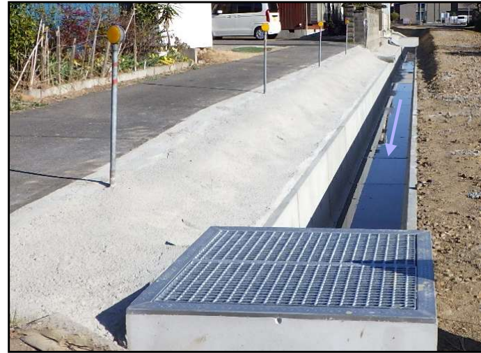
写真 排水路整備工事前後 (上：工事前、下：工事後)
