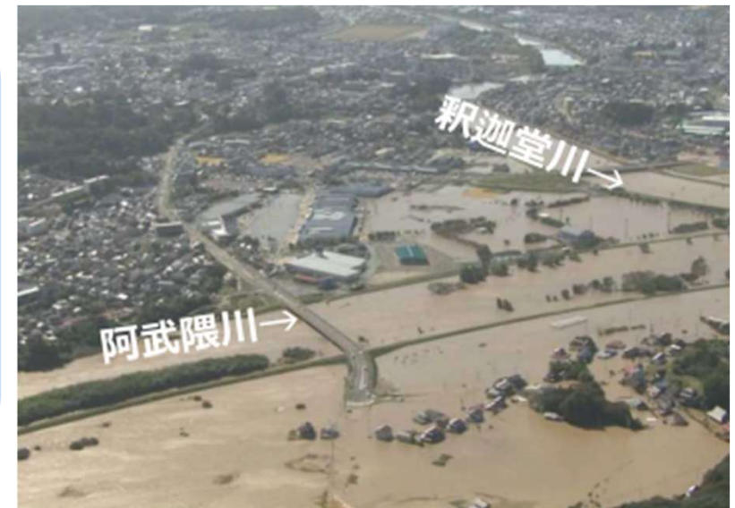
図 被災写真（令和元年東日本台風）
