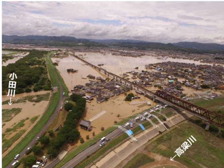
図 被災写真（平成30年7月豪雨）
