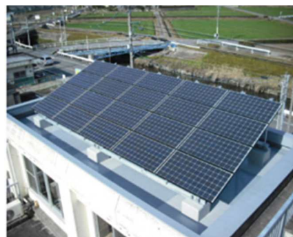
消防署東出張所に導入された屋根置き太陽光発電
