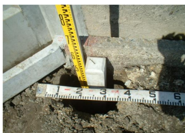
コンクリート杭
