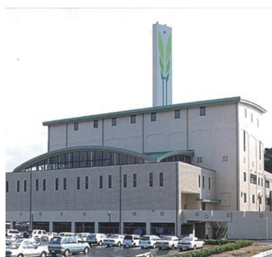
平成12年から稼働している西尾市クリーンセンターの焼却棟
