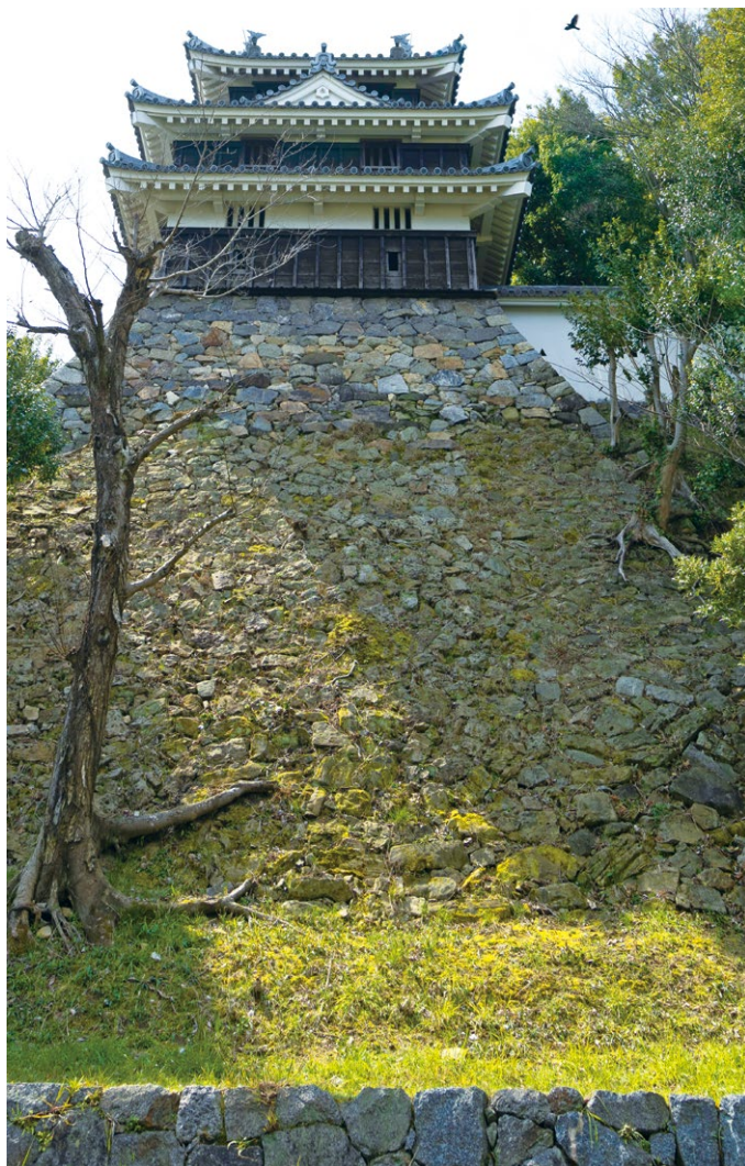
丑寅櫓北側石垣（北から撮影）
