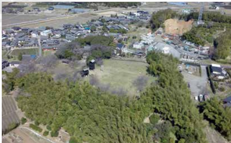
手前の大きな空間が主郭となります。現在、櫓・城門は撤去されています。 城館遠景(南から／平成25年撮影)
