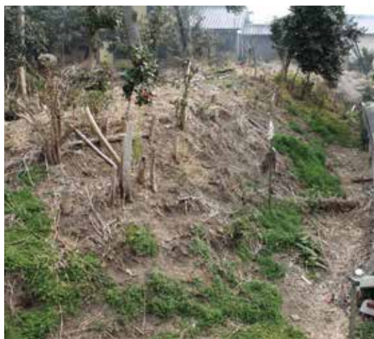
土塁全景(北から)
