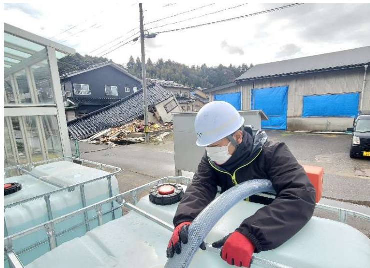
奥原町集会所給水タンク
