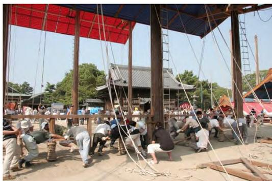
図 2-119 「カグラサン」で屋根形覆を引き上げる
