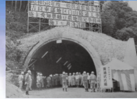
白山トンネルの貫通式
