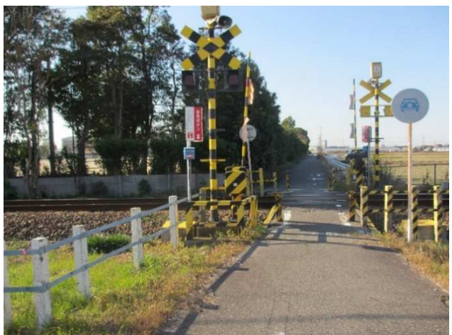
④ 北側道路（踏切手前側より）
