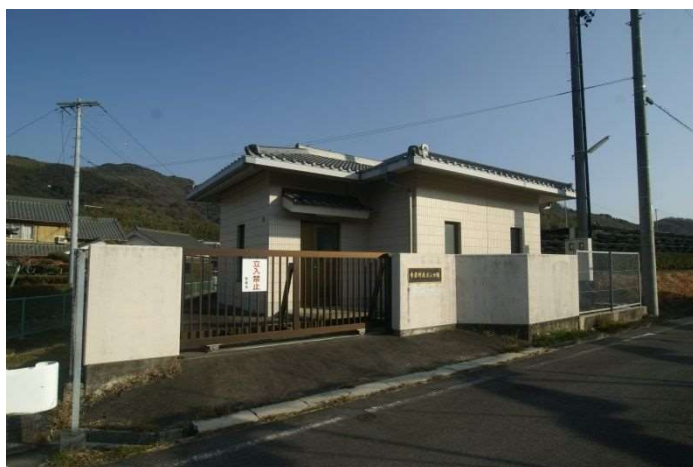
◆寺前増圧ポンプ場◆
