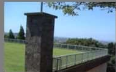
八ツ面第3配水池（10,000m 3 ）
