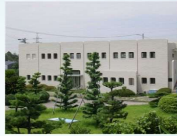
志貴野水源送水場
