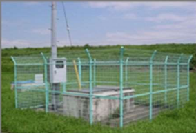
取水井（深井戸）
