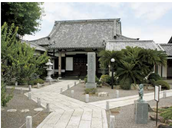
①⑨法蔵寺（浜松市南区）浄土宗鎮西派 吉良義堯の妻が創建にかかわっています。
