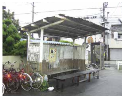
西尾鉄道港前駅跡（平坂町） 現在はバス停として利用されている。
