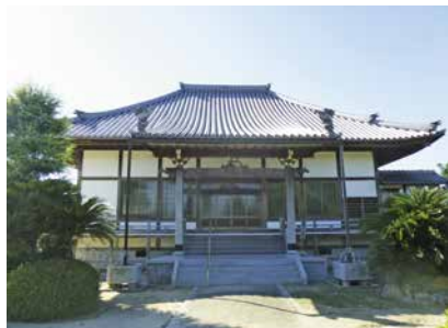
① 満国寺（一色町味浜） 本堂は、1671年に建てられた。老朽化が進んだため、1995年に改築された。
