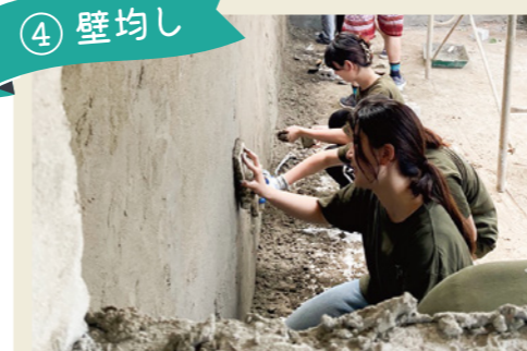
なかなかコンクリートが壁に付かなくて苦戦...
