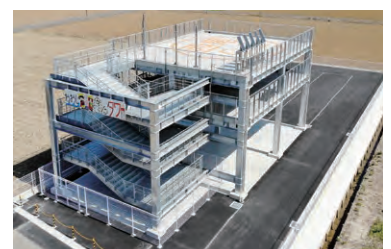
津波避難タワー建設事業 (3億5,069万円)
