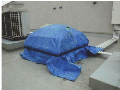
トップライトの状況（図書室）
