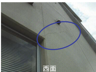
外壁の錆汁を伴うひび割れ
