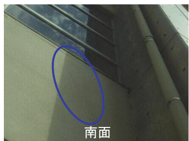
外壁の錆汁を伴うひび割れ
