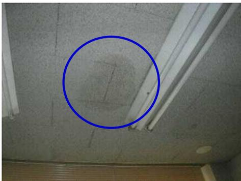
建築物内部への漏水・遊離石灰
