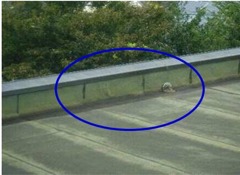
屋根材の劣化（防水層の膨れ）
