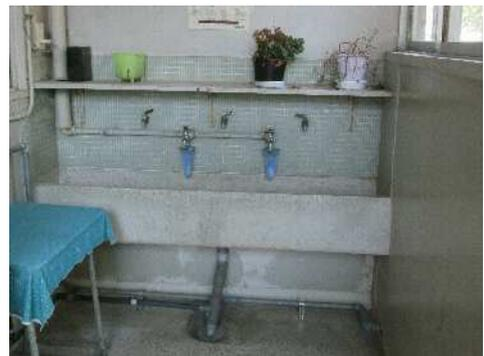
衛生設備の老朽化（水道の一部停止）
