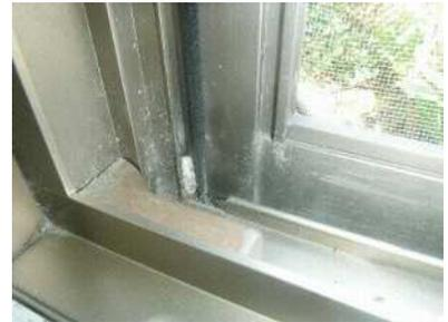
窓枠隙間からの雨漏り
