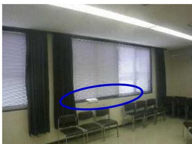
窓枠からの雨漏り痕
