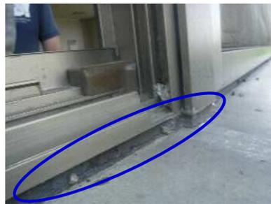
窓枠目地材の劣化
