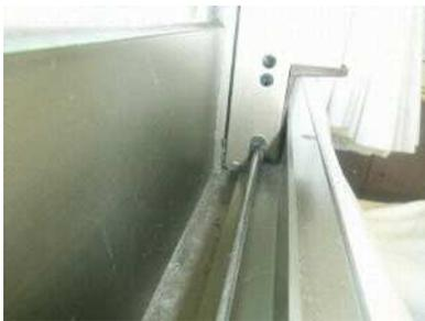
窓枠隙間からの雨漏り
