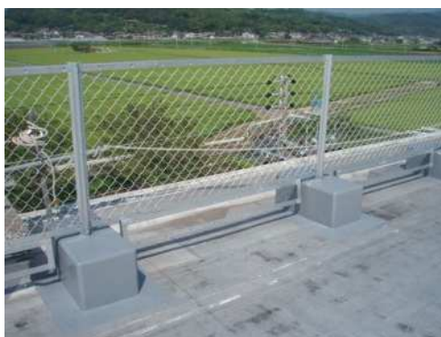
【屋上手すりの設置】
