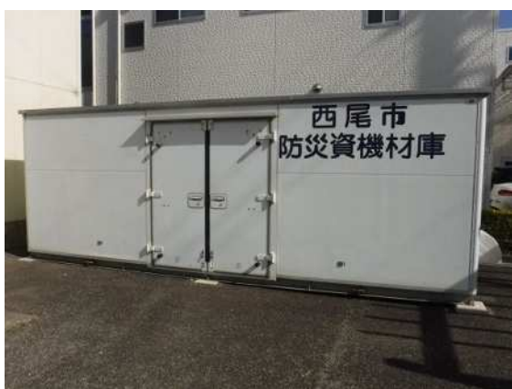
【西尾市防災資機材庫】
