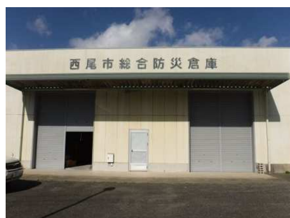
【西尾市総合防災倉庫】
