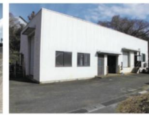
浸出液処理施設
