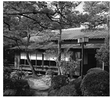
改修時にあわせ、文化財の価値に支障のない範囲内で耐震対策が講じられる尚古荘
