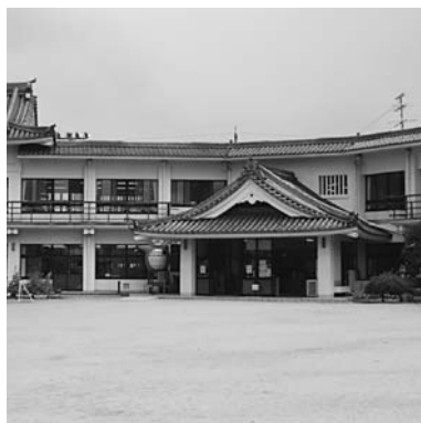
飛散防止フィルム工事が施工される市立幼稚園
