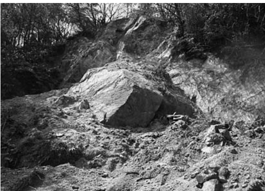
崩落防止対策が施される善明市民運動広場の現場
