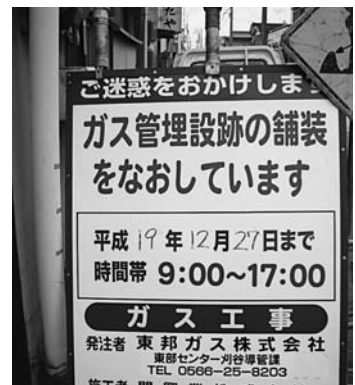
工事を告知する立て看板
