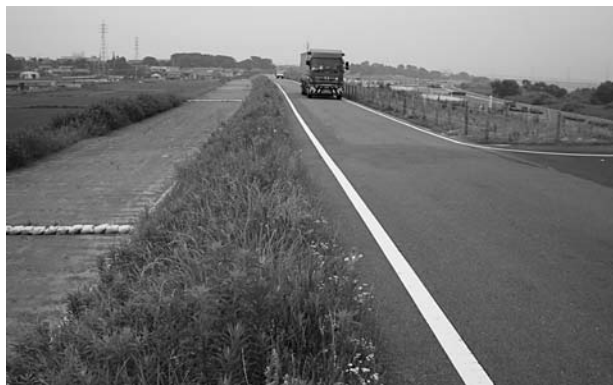
矢作川堤防の小段を道路として整備するリフレッシュ工事
