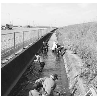
開水路の草刈り、泥上げ活動
