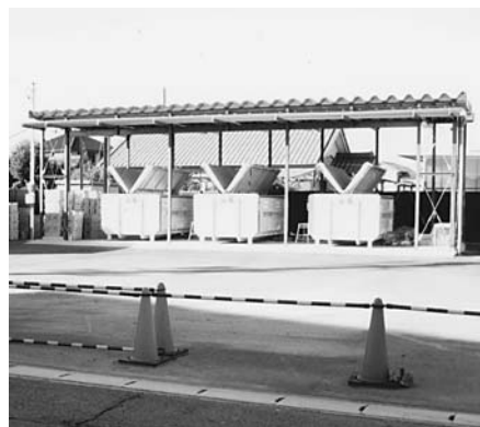
平坂常設資源ステーション
