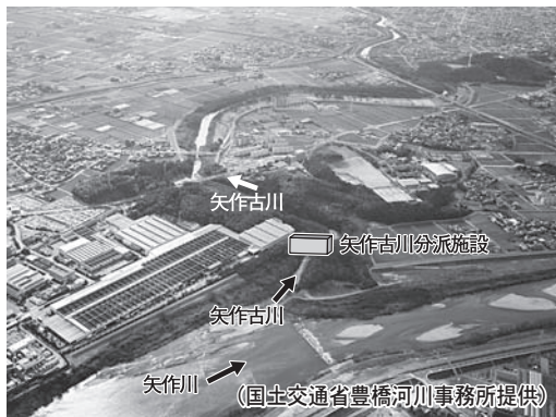
洪水時に矢作古川への流量を調整する矢作古川分派施設の予定地
