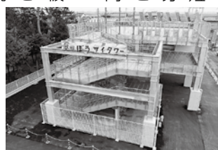
津波避難タワー
