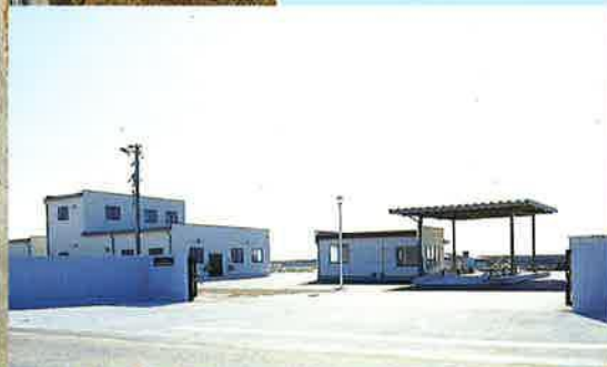
● トラックスケール・管理棟
