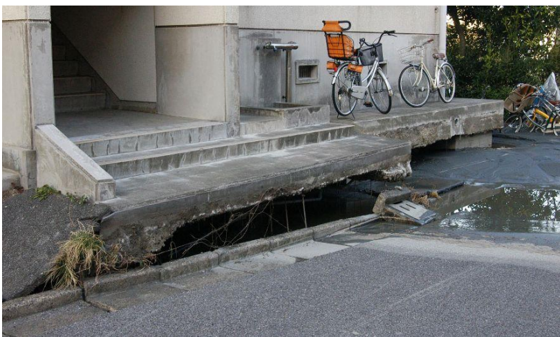
《 地盤沈下でできた段差 》
