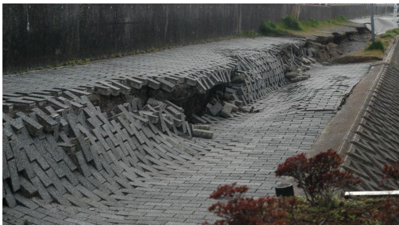
《 地盤沈下でできた段差 》
