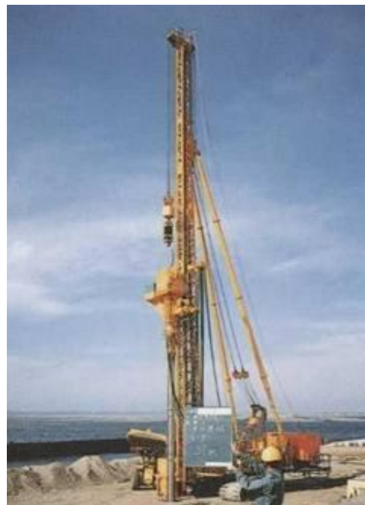
地盤改良による耐震対策の効果のイメージ図 サンドコンパクション工法施工写真 吉良海岸
