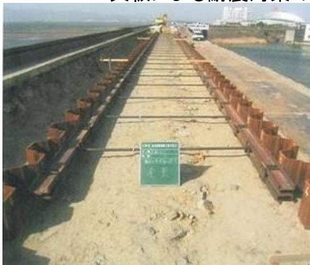
二重鋼矢板工法施工中写真
