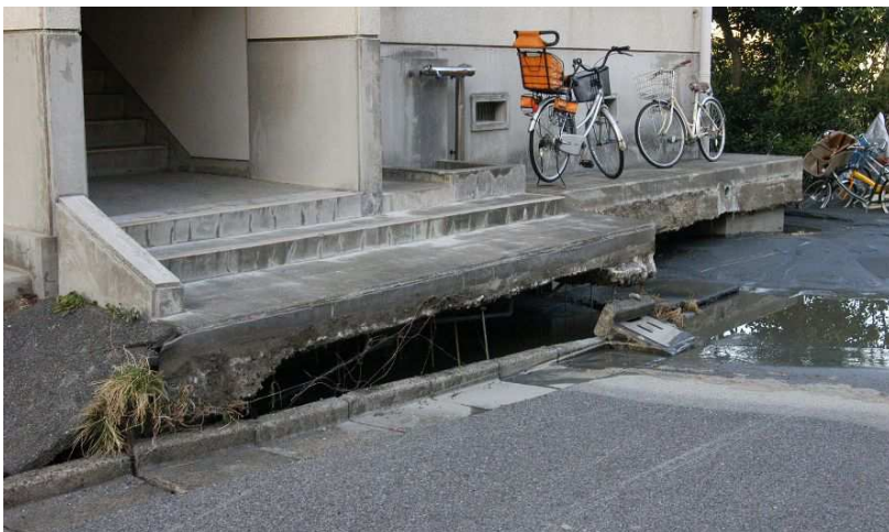
《 地盤沈下でできた段差 》
