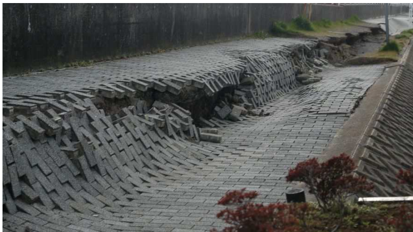
《 地盤沈下でできた段差 》
