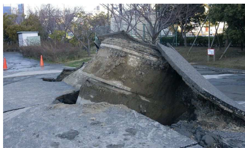
《 地面から飛び出したマンホール 》
