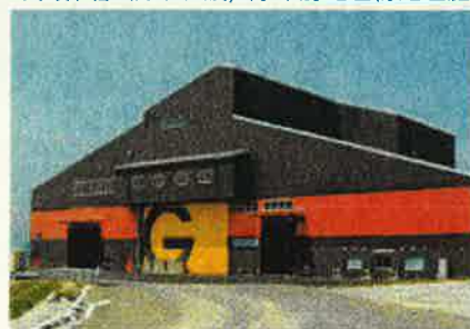
中間保管・梱包施設/特殊前処理物処理施設全景
