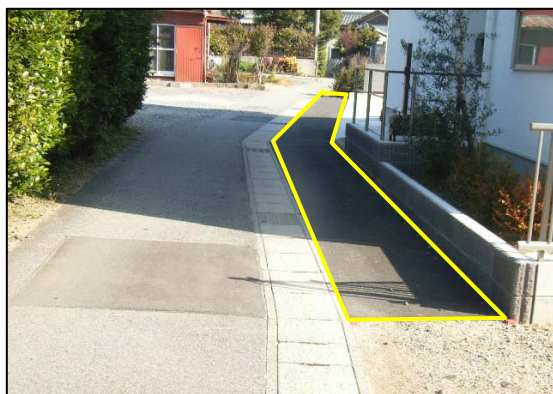
狭あい道路拡幅の様子
