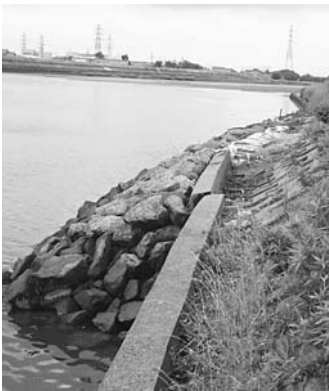
応急処置の大島側堤防
