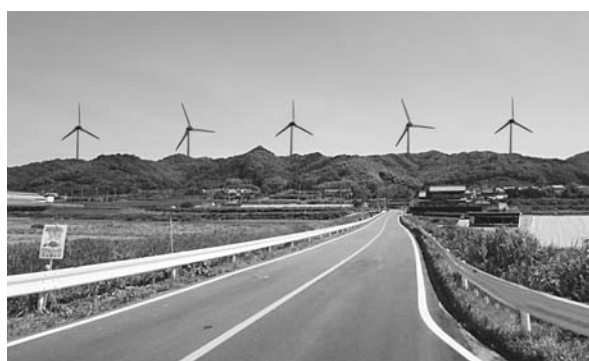
風力発電建設計画が浮上した建設予定地（風車はイメージ） 矢崎川籠田橋から南方の稜線（山の尾根）を望む
