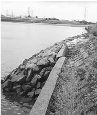
応急処置の大島側堤防
