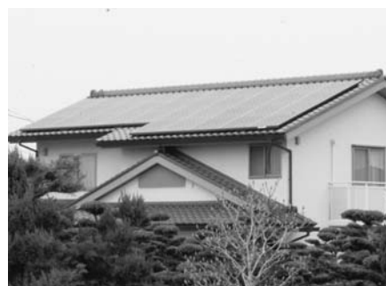
▲住宅の屋根に設置された太陽光発電装置
