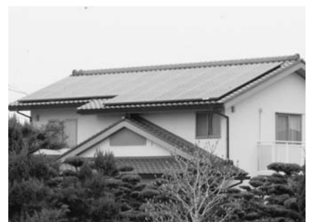
▲住宅の屋根に設置された太陽光発電装置
