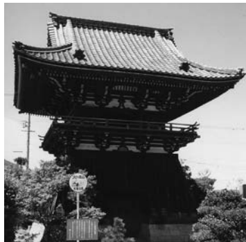
▶修理前の西福寺鐘楼
