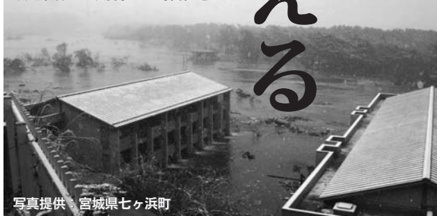
●大津波により浸水した町営住宅
