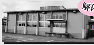
吉良防災倉庫
