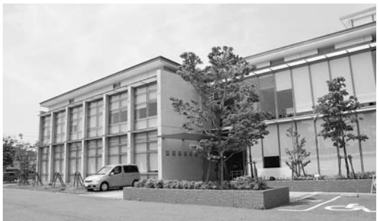
幡豆いきいきセンター
