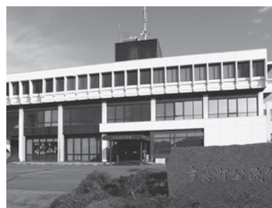
利用者の安全を確保するため解体予定の吉良町公民館
