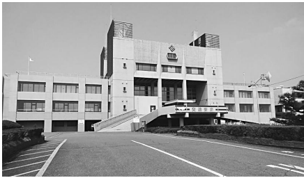
一色支所は解体され、跡地には防災機能を備えた多機能型市営住宅の建設が検討されている。
