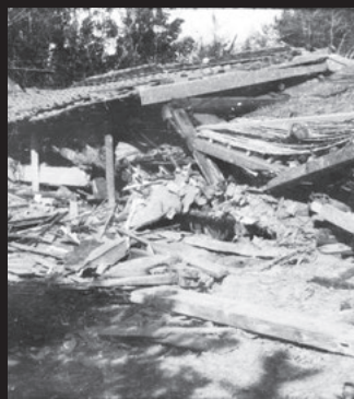
三河地震で倒壊した市内の建物 (萩原律氏撮影)
