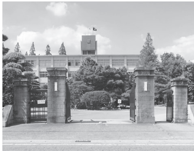
愛知県立西尾高校正門門柱／旧愛知県西尾中学校の正門として昭和5年ごろに建築。柱頭部の装飾がアカンサスの葉を模しているのが特徴
