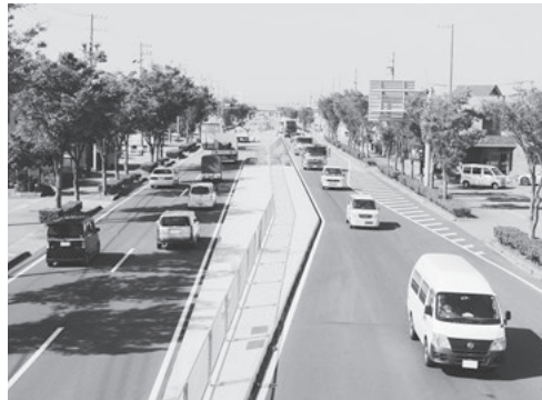
4車線化が進む上矢田南交差点付近
