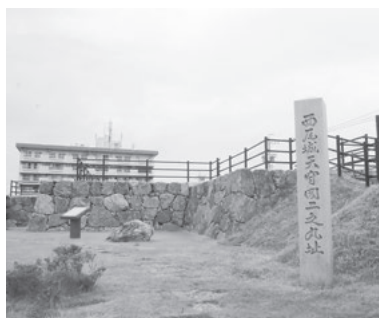
再建済みの二之丸の天守台
